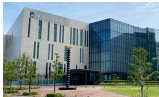
「富岳」が設置されている理化学研究所
